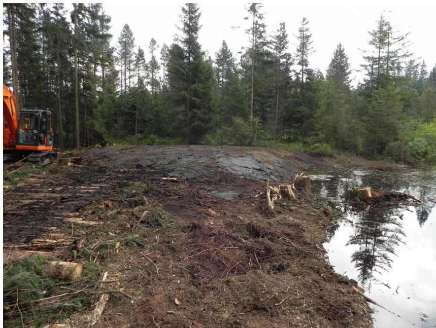
Dammbau in einem entwässerten Hochmoor, Bild: Allgäuer Moorallianz
